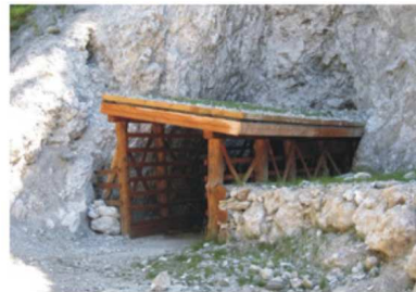
Cumbe Surde, Signols, Oulx, ingresso cava di gesso, estate 2010
